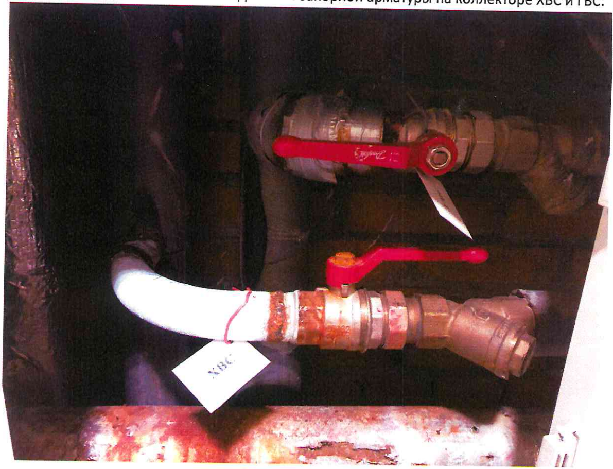
17 этаж, коррозия резьбового соединения запорной арматуры на коллекторе ХВС:
