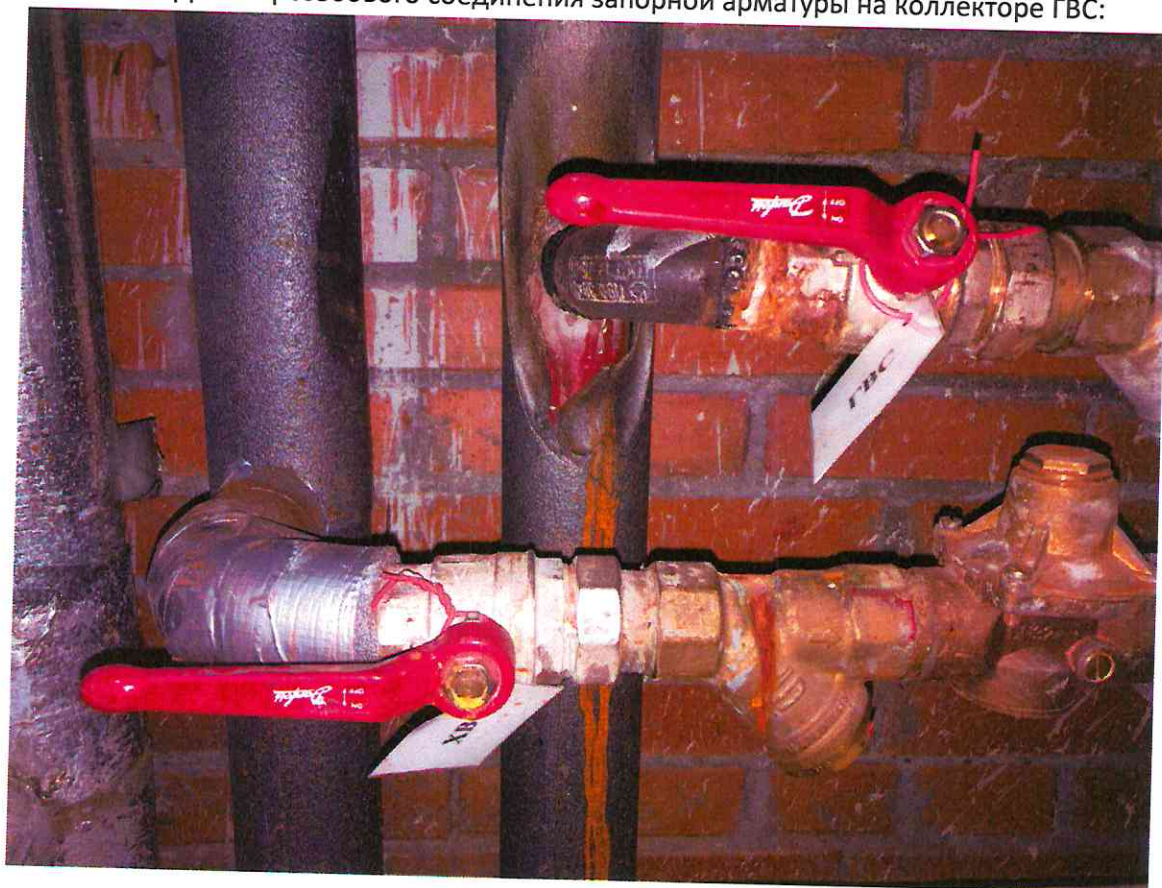
13 этаж, коррозия резьбового соединения запорной арматуры на коллекторе ГВС:
