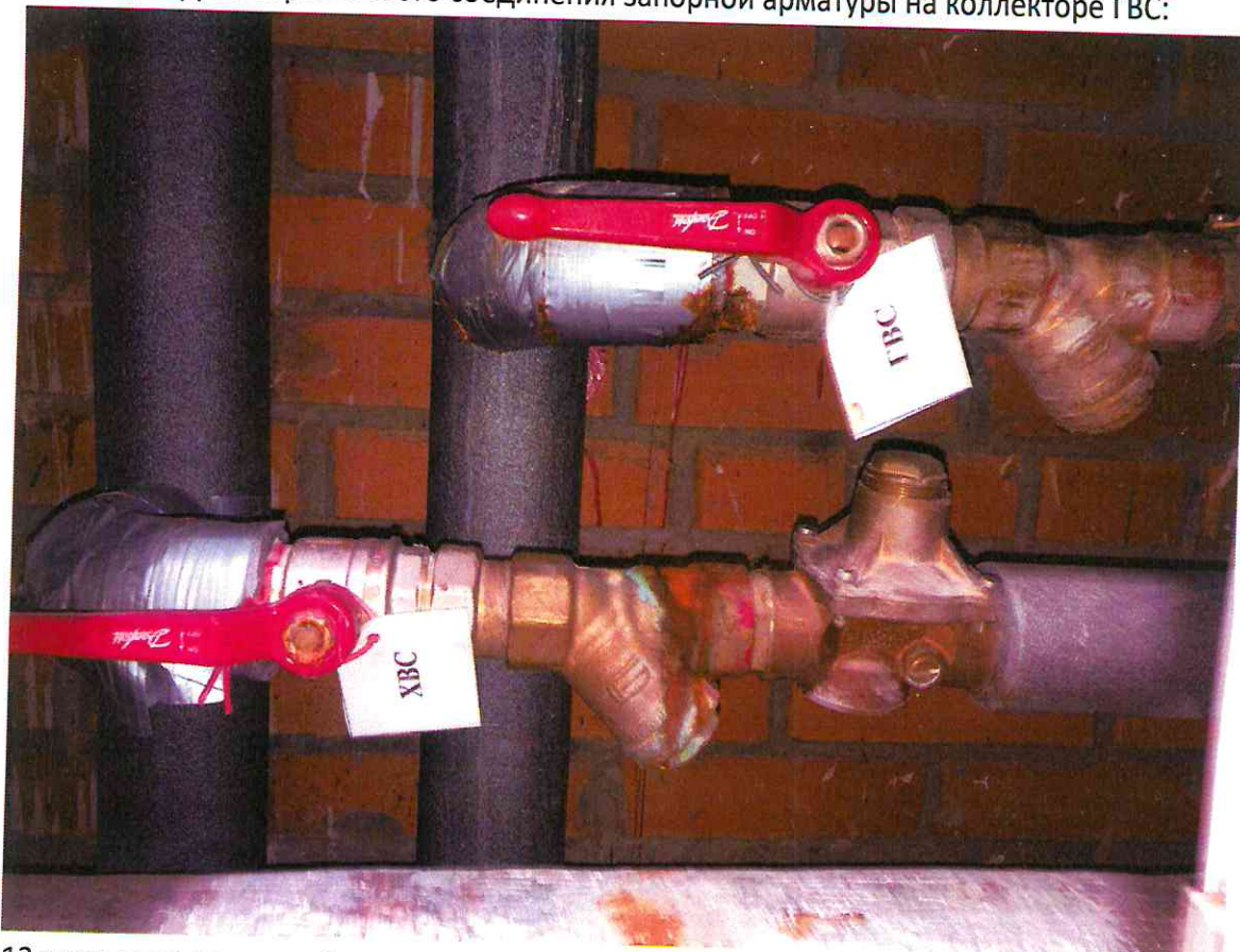
13 этаж, коррозия резьбового соединения запорной арматуры на коллекторе ГВС:
