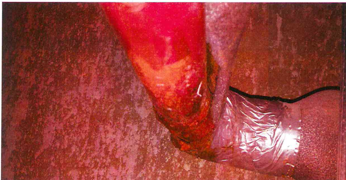
9 этаж, коррозия металла отвода ГВС:
