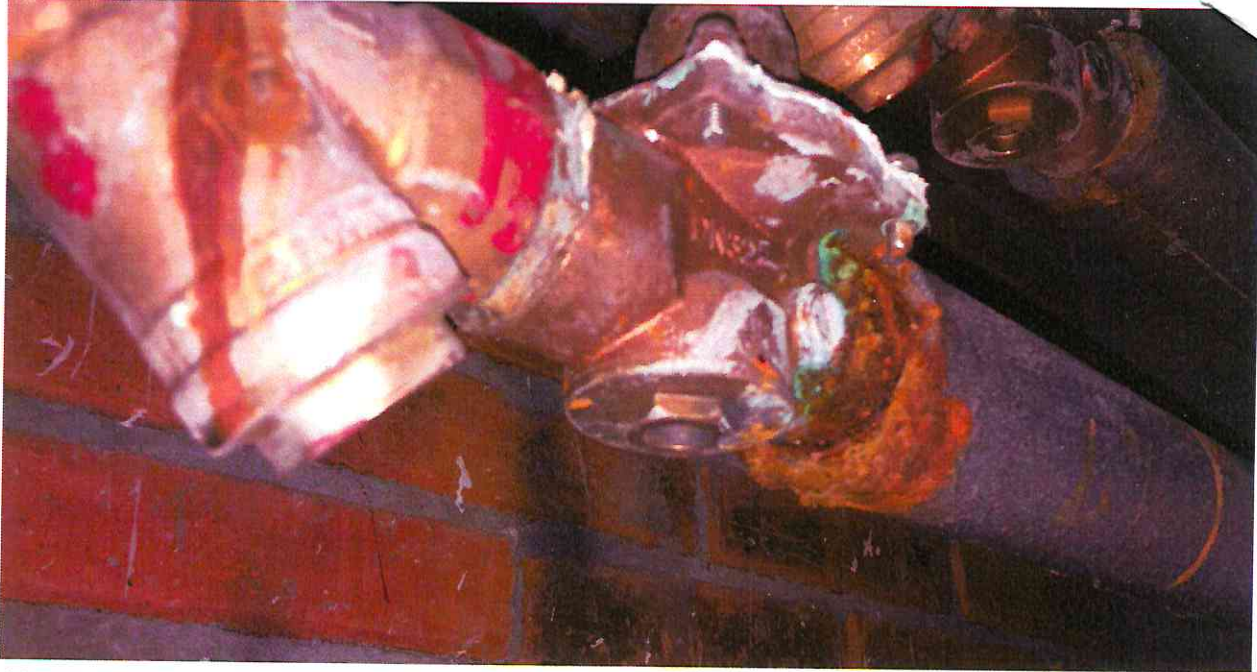
14 этаж, коррозия резьбового соединения запорной арматуры на коллекторе ХВС:
