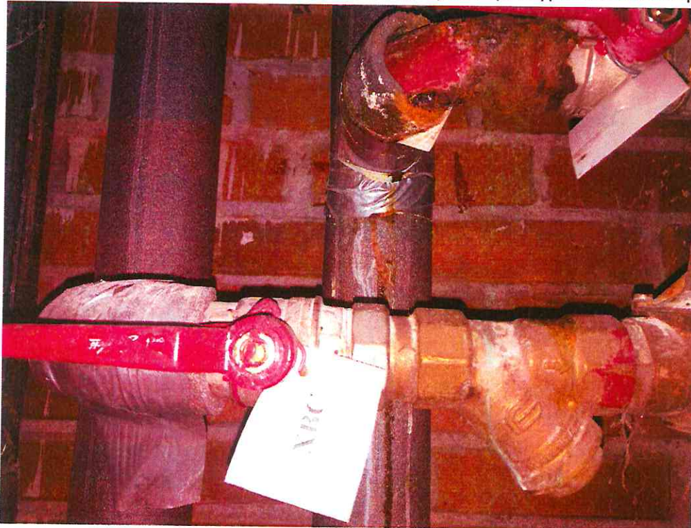
12 этаж, коррозия резьбового соединения запорной арматуры на коллекторе ГВС:
