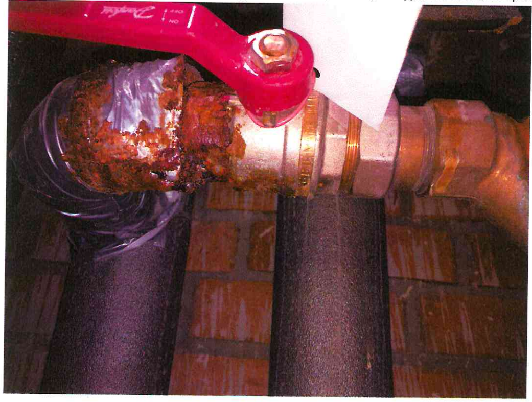
17 этаж, коррозия резьбового соединения запорной арматуры на коллекторе ХВС:
