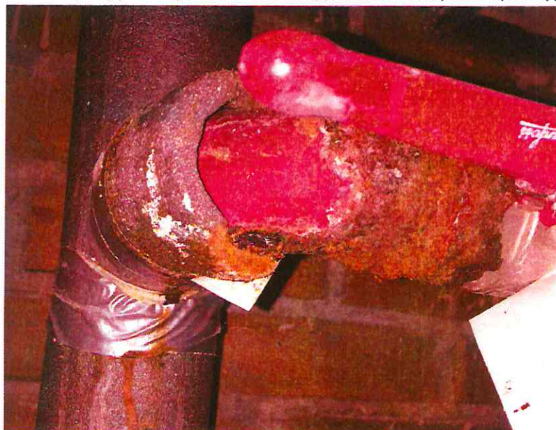
11 этаж, коррозия резьбового соединения запорной арматуры на коллекторе ГВС:
