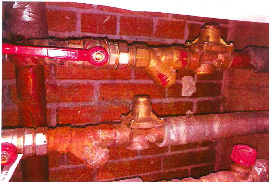
11 этаж, коррозия резьбового соединения запорной арматуры на коллекторе ГВС:
