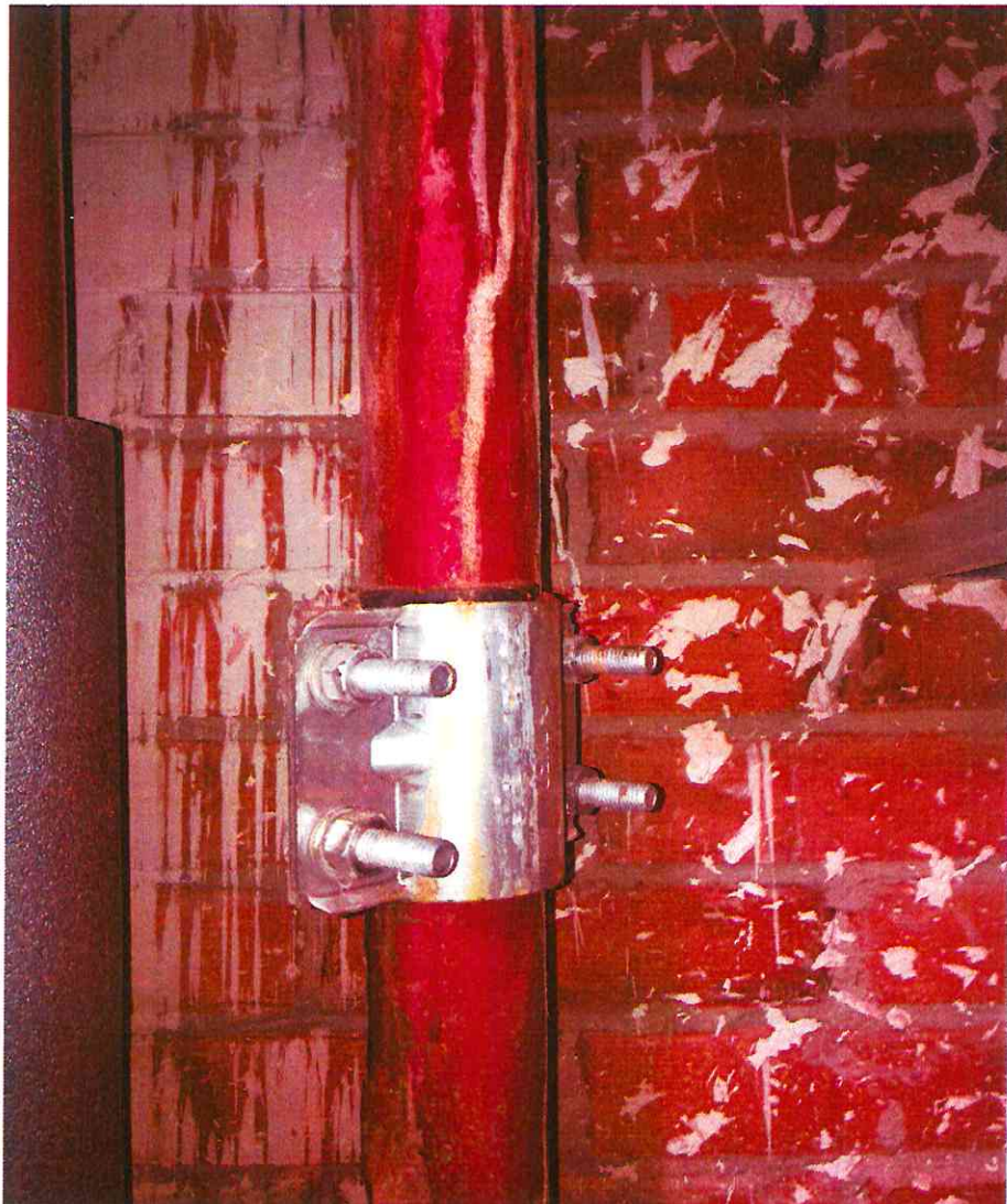
9 этаж, коррозия металла отвода ГВС:
