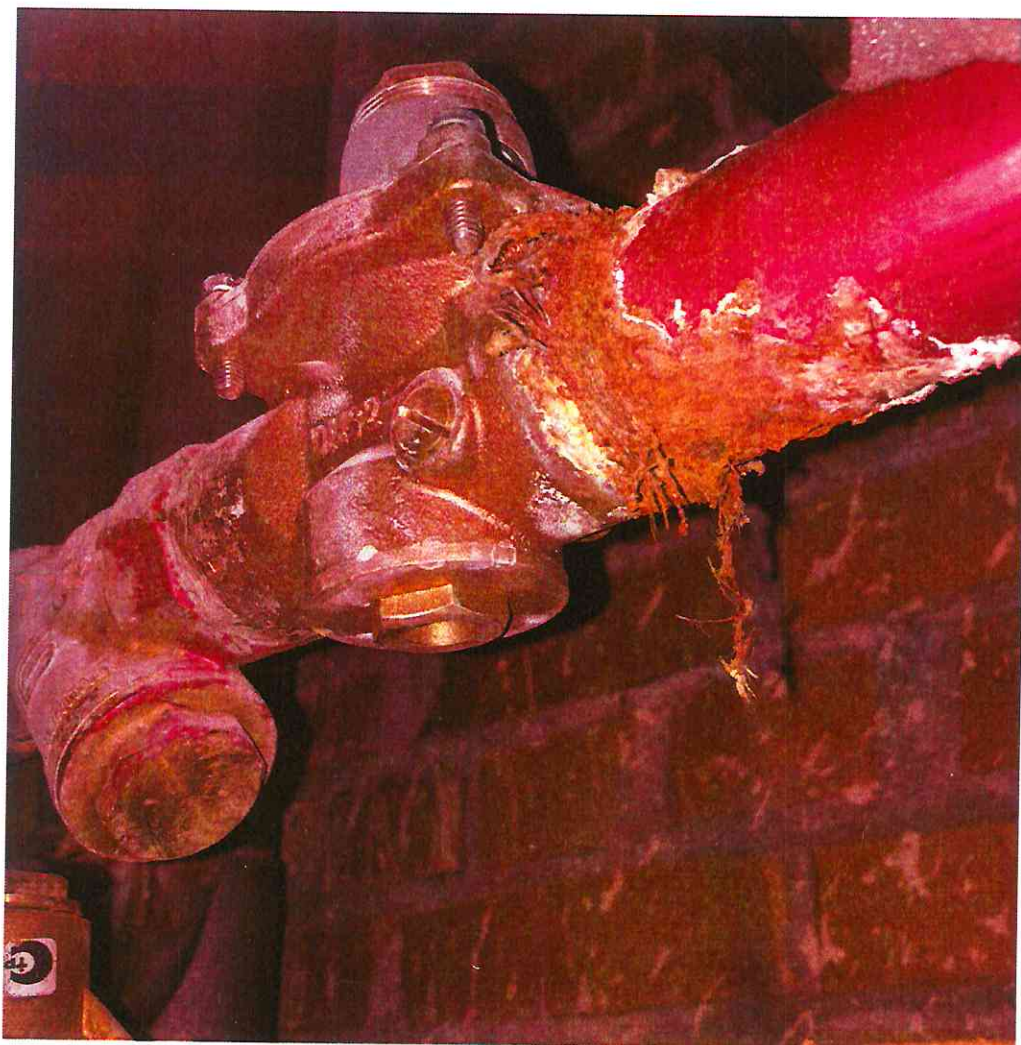
12 этаж, коррозия резьбового соединения запорной арматуры на коллекторе ГВС:
