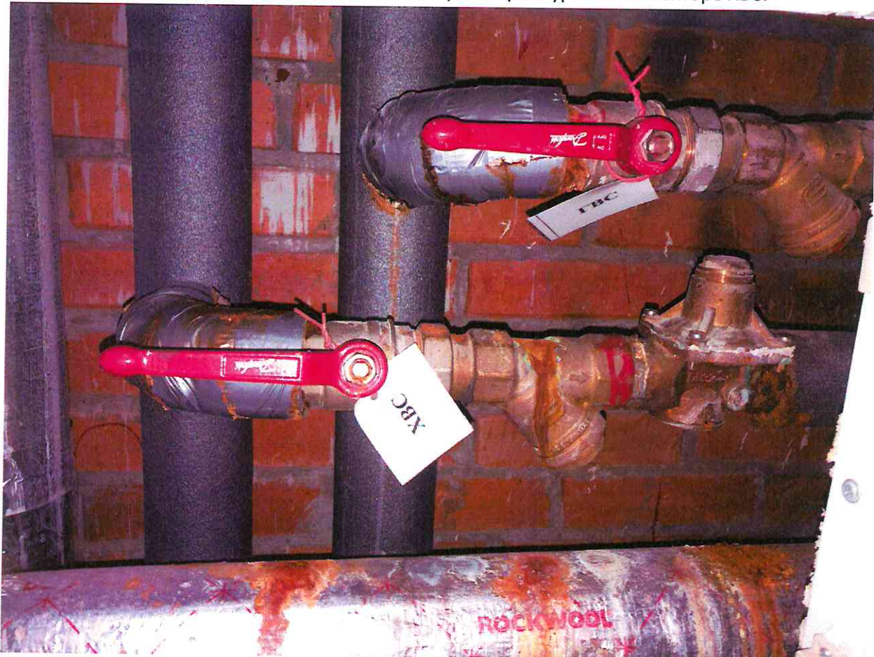
14 этаж, коррозия резьбового соединения запорной арматуры на коллекторе ХВС:
